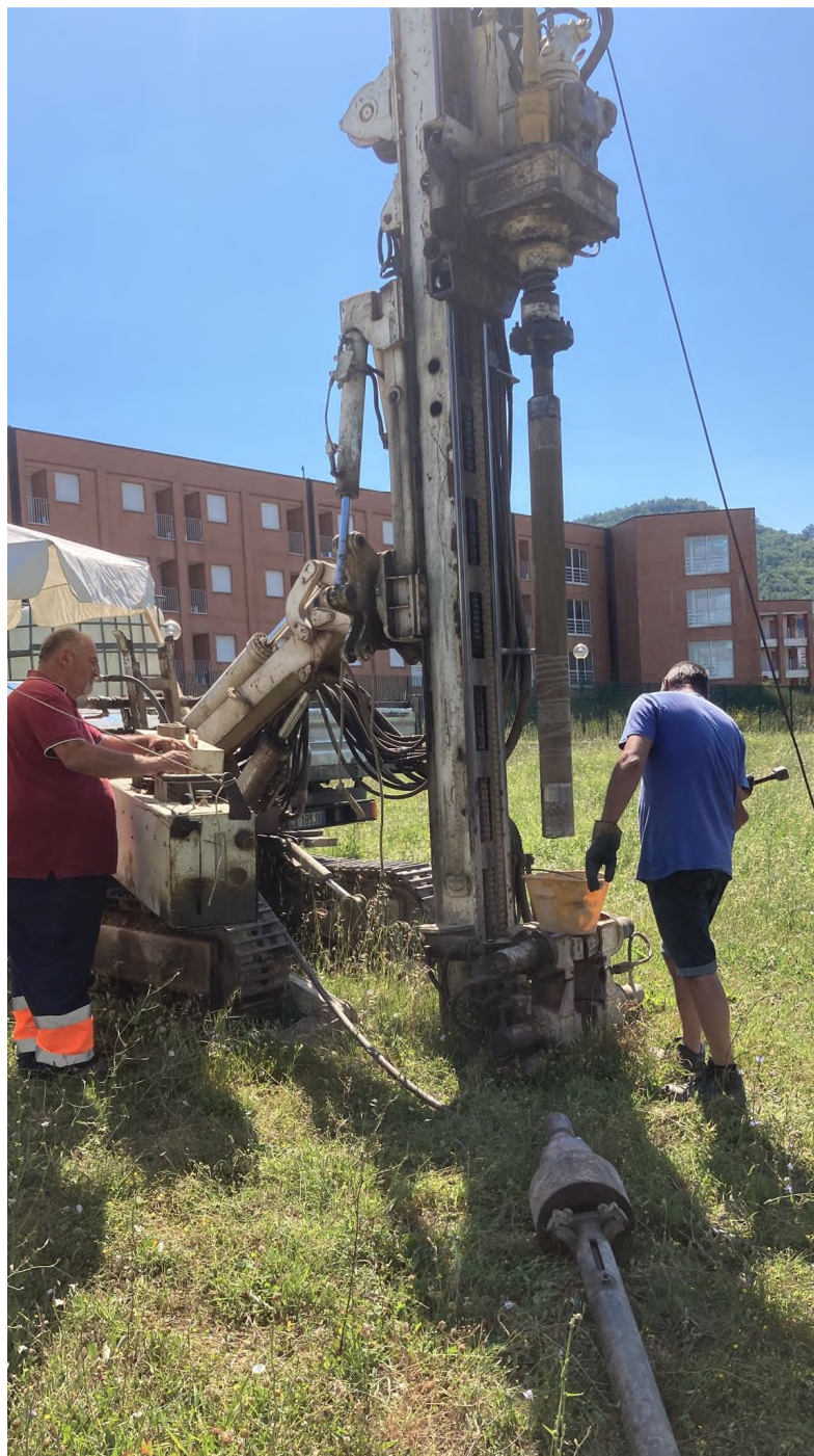
Postazione ed esecuzione sondaggio S5P2.
